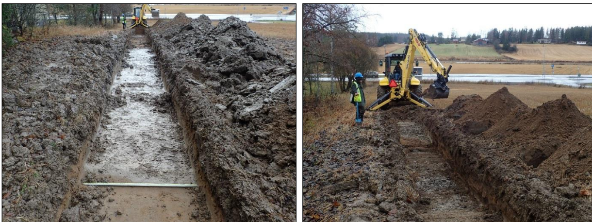
Koejaa nro 1. Luoteeseen. Koejaa nro 1 kaivetaan. Taustalla Porvoonjoki. Länsiluoteeseen.
